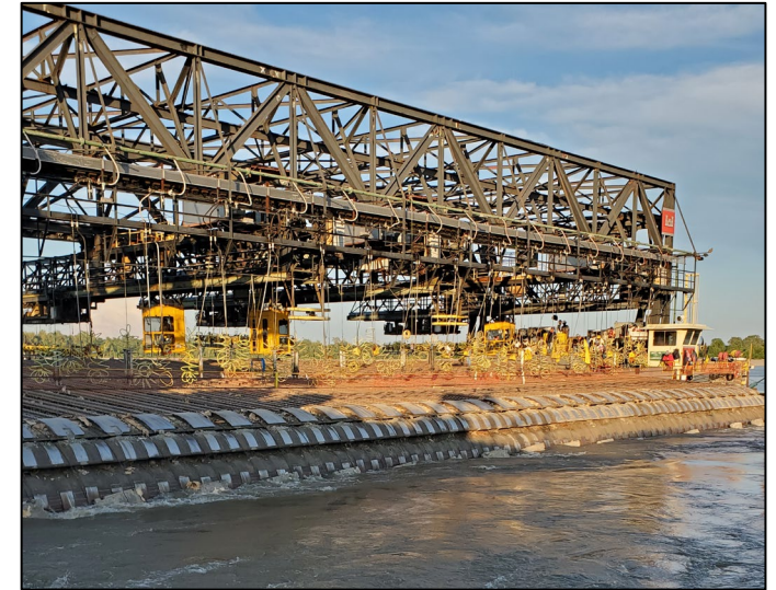
Mat Sinking Unit (MSU)
